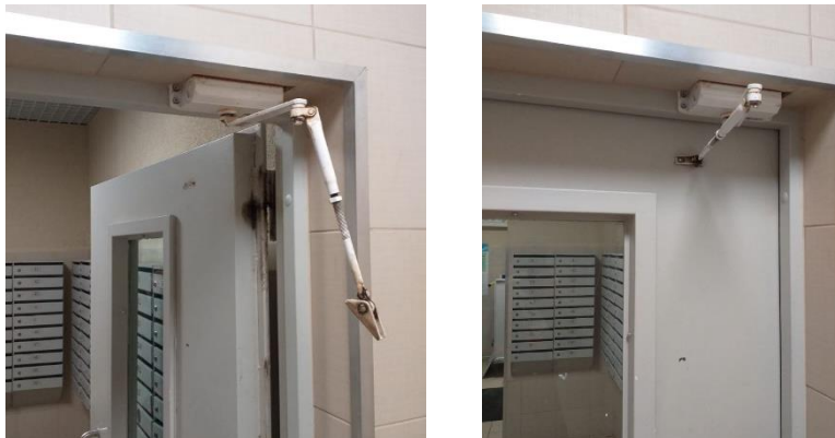
Замена доводчика: ул. Корнея Чуковского, д. 5, к. 2
