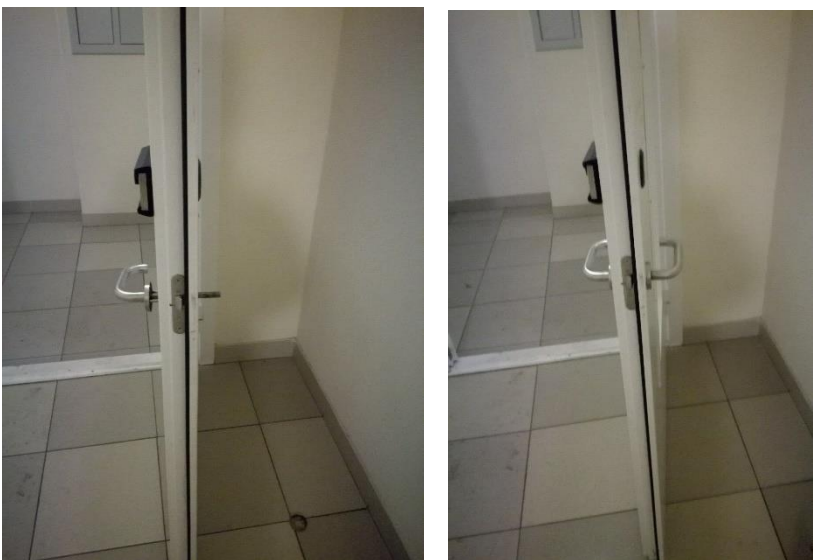
Ремонт дверной ручки: ул. Корнея Чуковского, д. 5, к. 2
